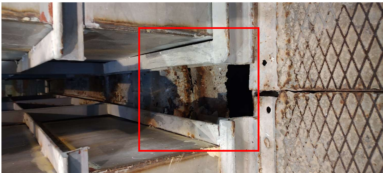
Obrázek 4 - Koroze profilu nádrží
