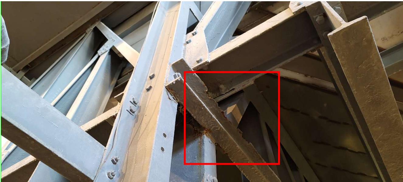
Obrázek 5 - Úbytek tloušťky profilu
