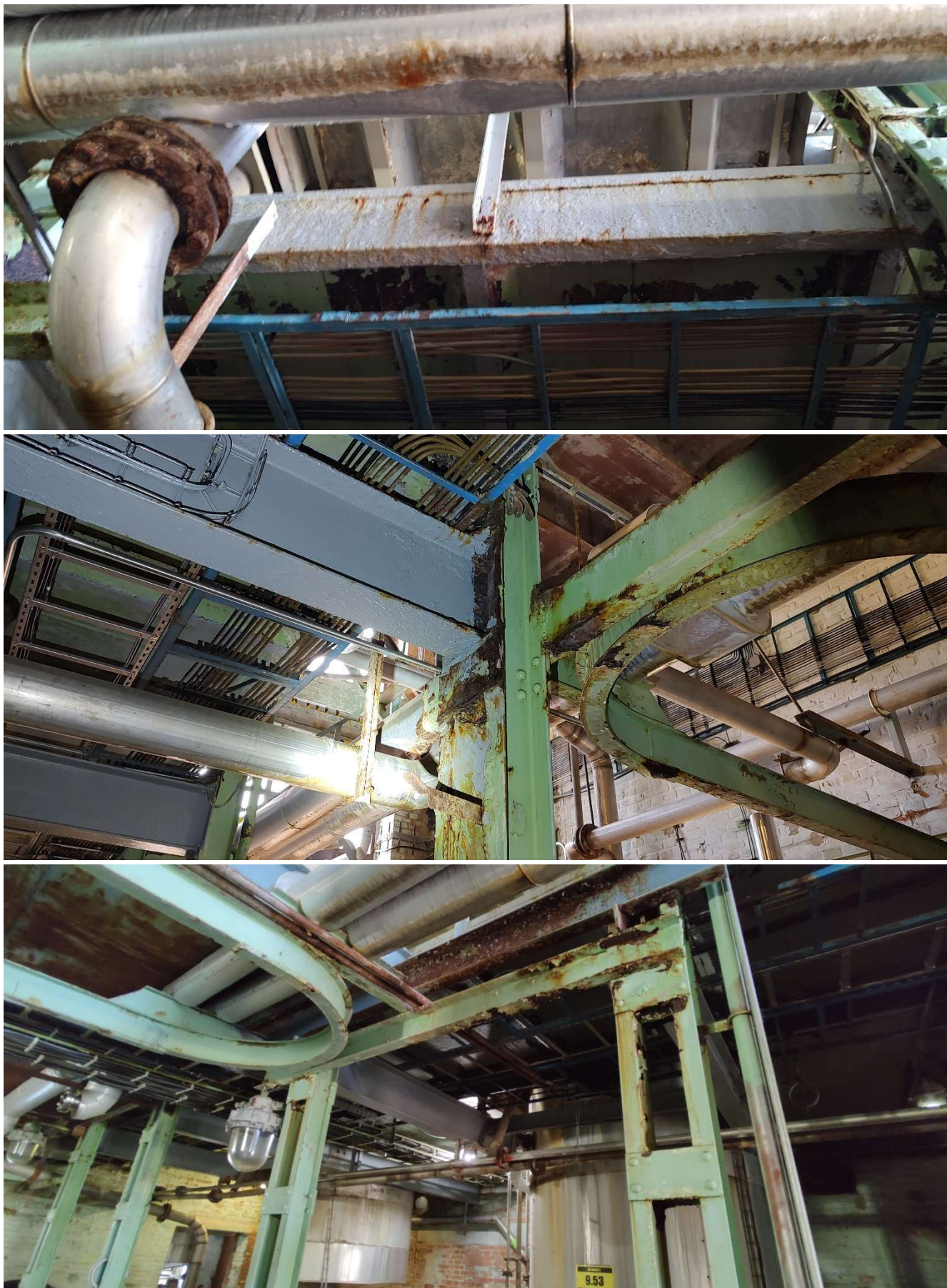
Obrázek 6 - Současný stav protikoroziční ochrany
