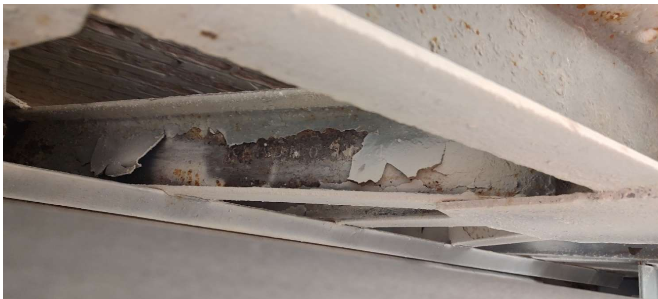
Obrázek 7 - Současný stav protikoroziční ochrany
