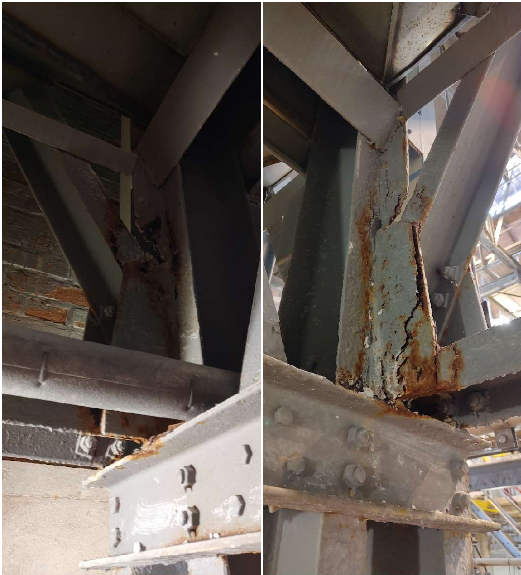
Obrázek 6 - Koroze v místě styčnicku příhradové konstrukce
