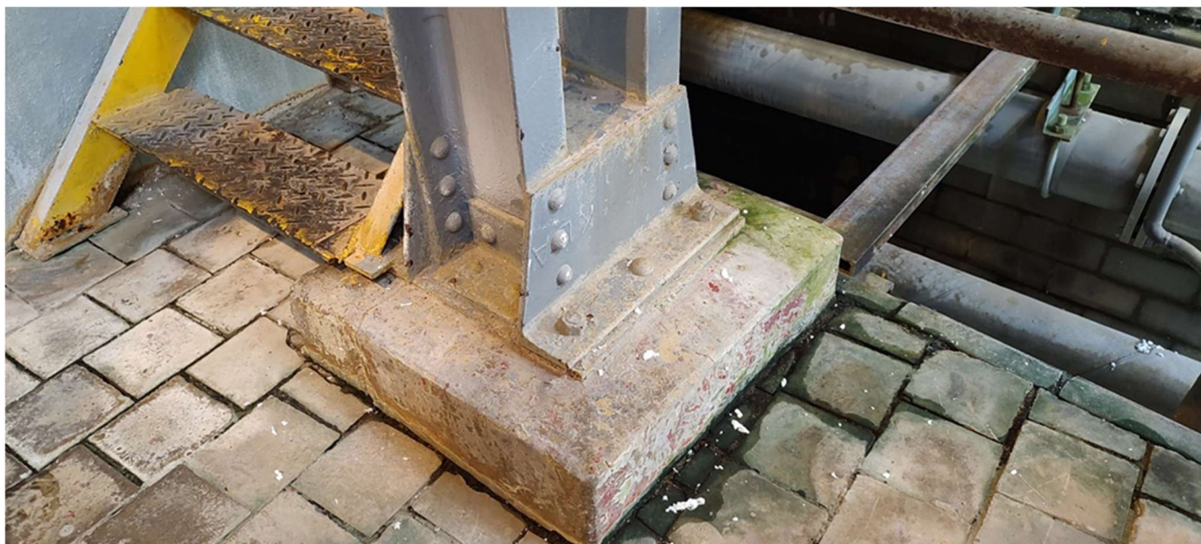
Obrázek 3 - Kotvení sloupu / konstrukce
