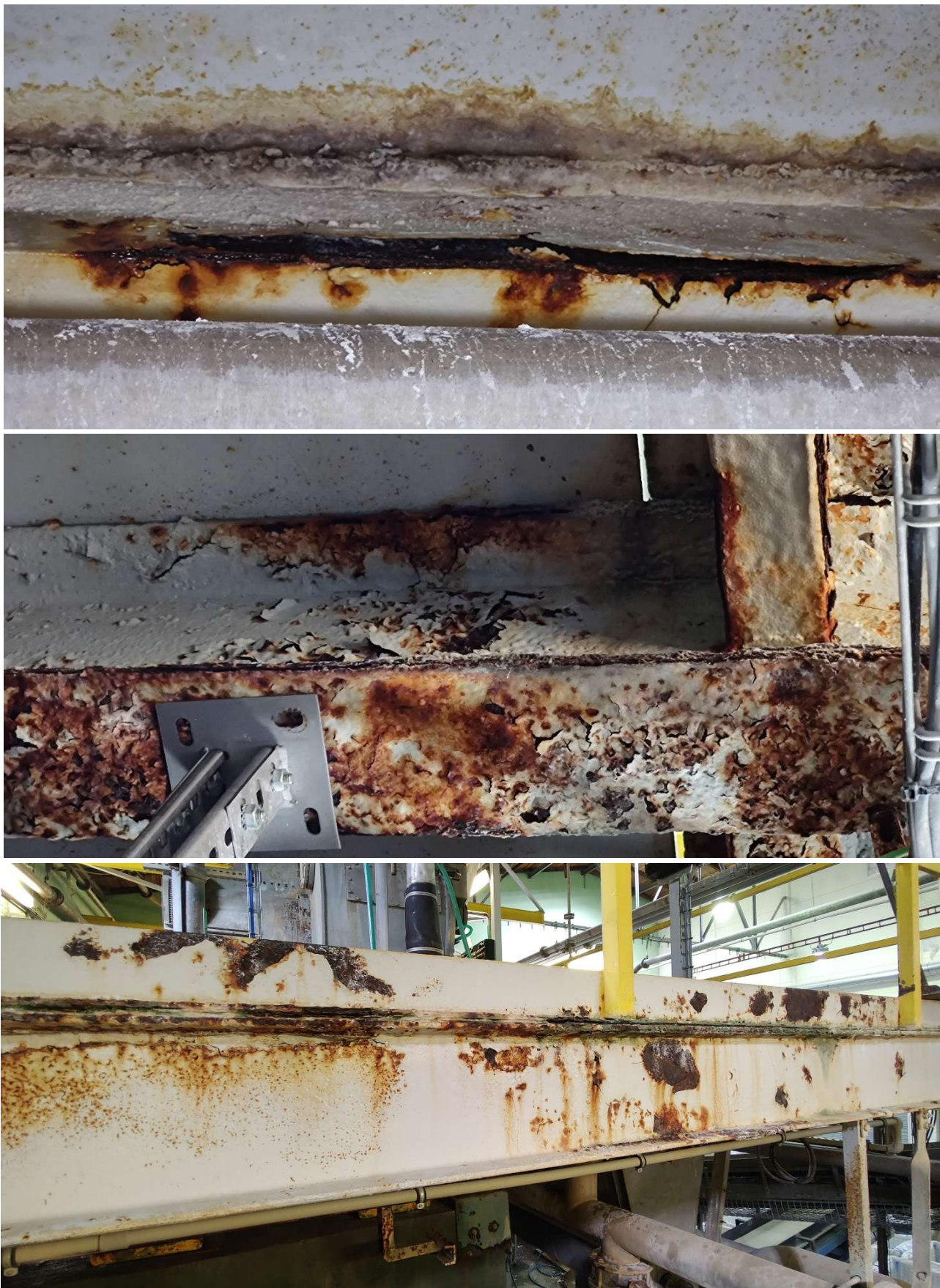
Obrázek 4 - Současný stav protikoroze ochrany
