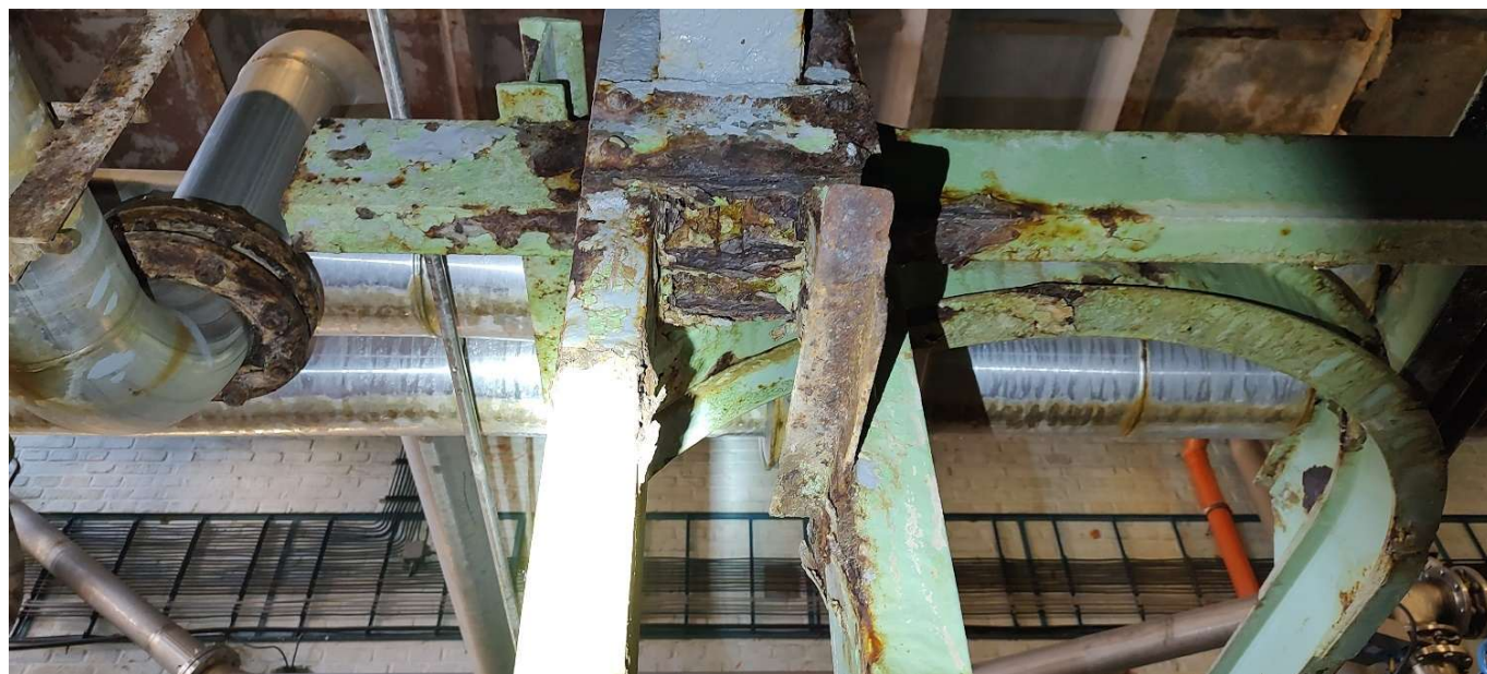
Obrázek 5 - Detail podepření hlavního nosníku
